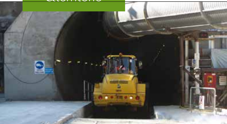
3. L'ingresso del cunicolo di cantiere TELT-Nicchie
