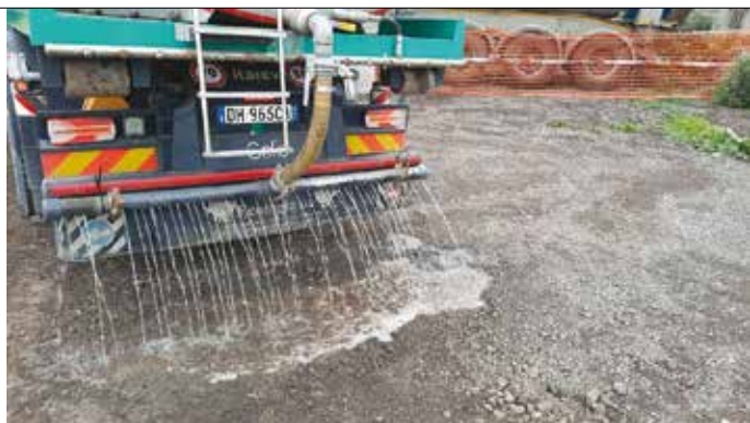
6. L'attività di bagnatura delle piste al cantiere Terna
